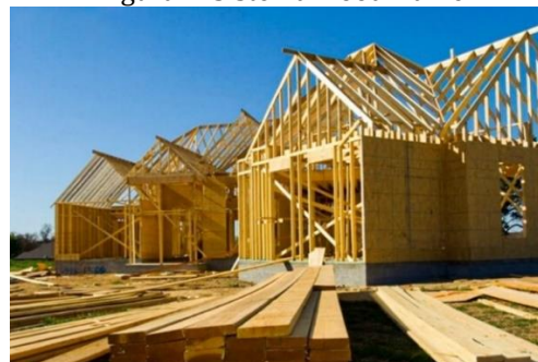
Figura 4. Sistema wood frame
